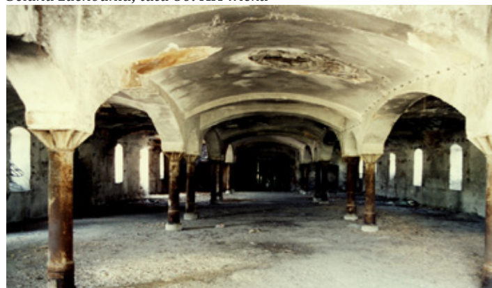
Wnętrze nieistniejącego spichlerza, czerwiec 2021
