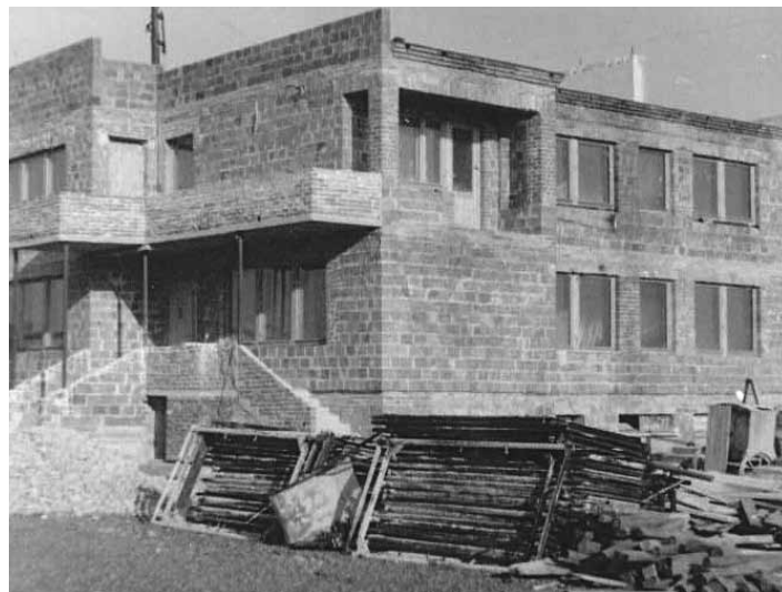
Budowa probostwa przy kościele św. Stanisława Biskupa i Męczennika w Jawornicy Źródło: Zdjęcie z Kroniki Parafii w Jawornicy.
