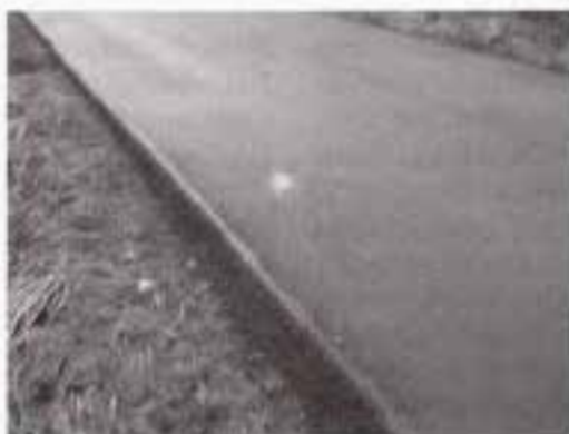
Wyremontowany odcinek drogi
