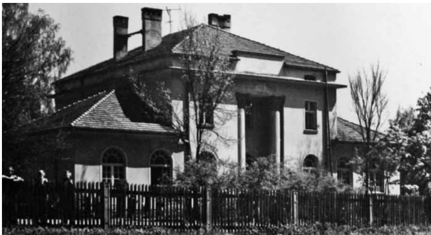
Szkoła podstawowa w Piasku. Rok budowy 1926.
