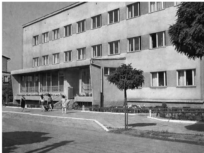
Nowy budynek poczty przy ul. Karola Miarki
