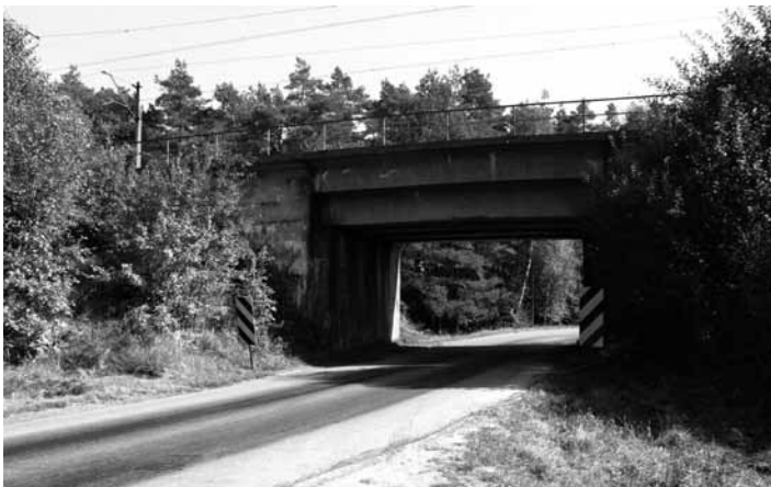
Puszczewski Most. Fot. Adam Sołtykowski, 23 wrzesień 2007 roku.
