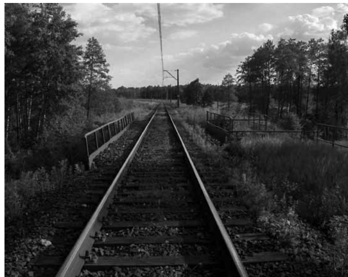
Kacapski Most – widoczne przyczółki pod budowę II toru. Fot. Zbigniew Chromik, 14 czerwiec 2006 roku.
