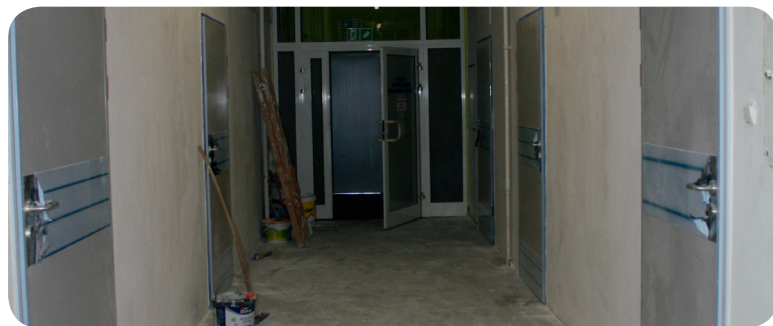
Prace remontowe na oddziale chirurgii trwają
