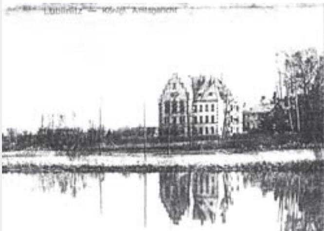
Budynek Sądu to dawny Królewski Urząd Sądowy. Na pierwszym planie rozlewisko, gdzie obecnie mieści się parking między ulicą Grunwaldzką a ulicą Sobieskiego (zdjęcie zostało opublikowane w albumie „Ziemia Lubliniecka - zielony zakątek Śląska”).
