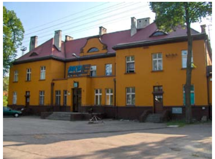
Budynek dworca w Herbach Nowych. Stan z 2007 roku, widok od strony ul. Wieczorka. Fot. Zbigniew Chromik
