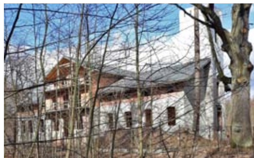
Czarny Las, budowla w remoncie, fot. 2019 r., BH
