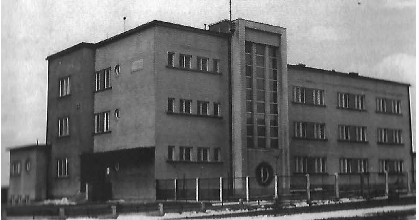
Budynek nowej szkoły w Woźnikach
