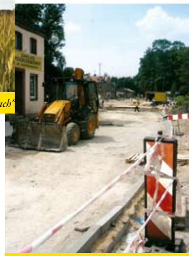
Barbara Ligarska „Lubliniec – budowa ronda – ul. Piłsudskiego”
