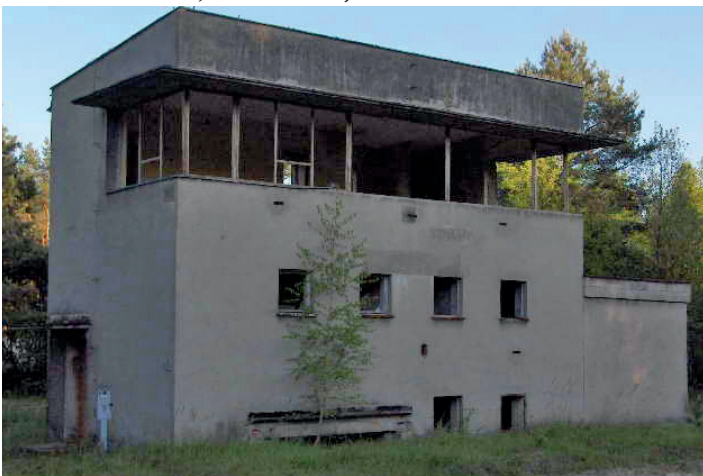
Opuszczone budynki na dawnej stacji Kokotek. Obecnie zburzone. Zdjęcie z dnia 20 maja 2005 roku, autor Zbigniew Chromik.
