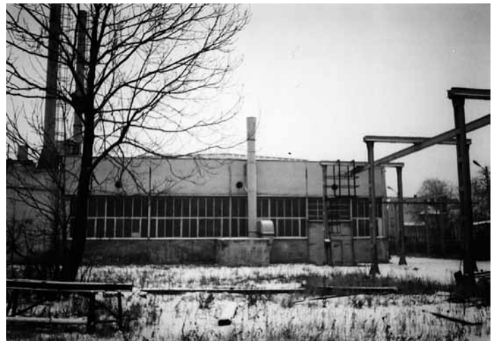
Hala produkcyjna z widoczną konstrukcją suwnicy – ok. 1995 r.
