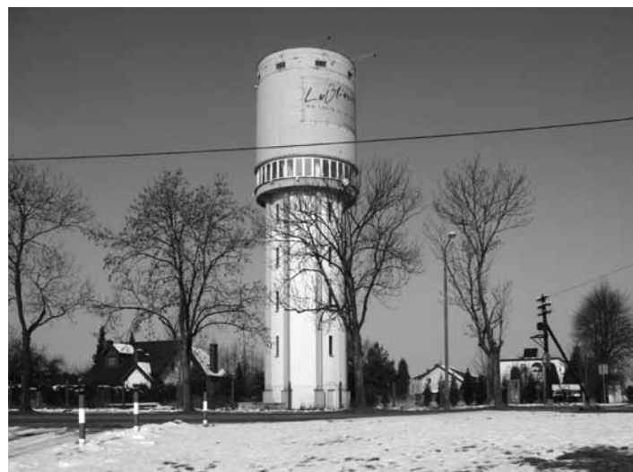
Lubliniec, wieża ciśnień. Stan obecny, 7 lutego 2015 roku. Fot. Grzegorz Trąbski.
