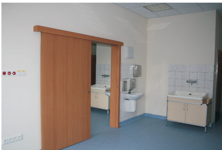
Dwie sale porodowe połączone drzwiami przesuwными z własnymi łazienkami. Sale znajdują się w trakcie porodowym o podwyższonych parametrach higienicznych. Ściany pokryte są specjalną wielowarstwową farbą zawierającą bakteriobójcze jony srebra. Sale wyposażone są w niezależną wentylację mechaniczną z klimatyzacją. Podłoga pokryta jest antystatyczną wykładziną spełniającą atesty higieny dla szpitali. Sale wyposażone są również w przepływowe lampy bakteriobójcze.
