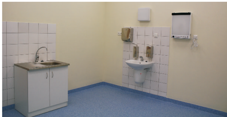
Gabinet zabiegowy na Oddziale Położniczym wyposażony w przepływową lampę bakteriobójczą z licznikiem czasu pracy. Ściany pokryte są specjalną wielowarstwową farbą zawierającą bakteriobójcze jony srebra.
