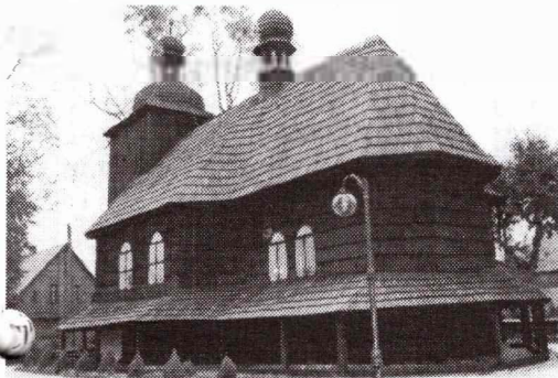
Kościół pw. św. Marcina w Cieszowicy
