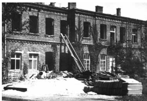
Sierpień 1975 - remont budynku po pożarze
