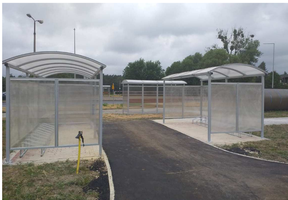
Rys. 17. Parking rowerowy w Lisowie w ostatnim stadium budowy (07.07.2019 r.). Opracowanie własne.
