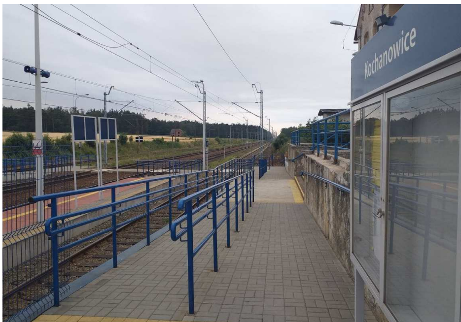
Rys. 13. Przebudowane przejście na perony przystanku kolejowego w Kochanowicach na linii nr 61. Źródło: opracowanie własne.
