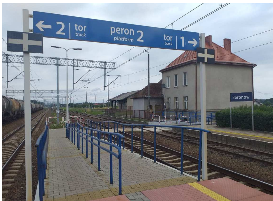
Rys. 21. Zmodernizowane przejście między peronami stacji w Boronowie. Opracowanie własne.
