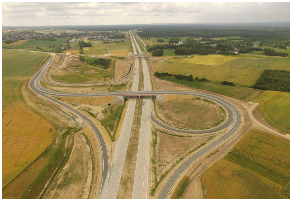
Rys. 12. Węzeł autostrady A1 w Woźnikach, w końcowej fazie budowy w czerwcu 2019 roku.
