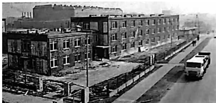
Budowa budynku internatu przyzakładowej szkoły zawodowej
