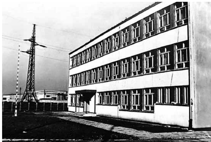
Budynek przyzakładowej szkoły zawodowej w Lublińcu
