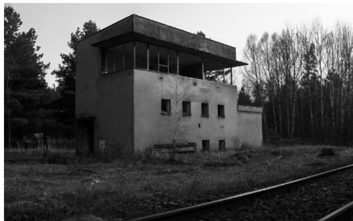
Nastawnia przy dawnym dworcu w Kokotku. Stan z 2007 roku. Obecnie budynek nie istnieje, został rozebrany podczas remontu linii kolejowej Nr 152 Pyskowice – Lubliniec w 2012 roku. Fot. Zbigniew Chromik, dnia 16 marca 2007 roku
