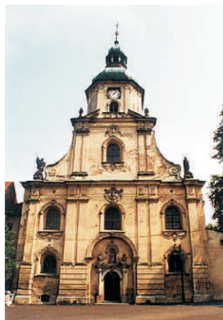
Fasada kościoła przed remontem. Stan sprzed 1994 r.
