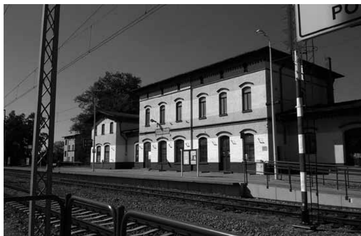
Herby Stare. Stan z 2016 roku. Źródło: https://upload.wikimedia.org/wikipedia/commons/thumb/0/09/Herby_Stare_train_station_-_station_building.jpg/1280px-Herby_Stare_train_station_-_station_building.jpg [dostęp dnia 21 grudnia 2020 roku]
