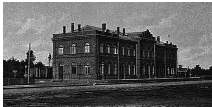
Stacja Herby Ruskie, budynek dworca. Z archiwum autora
