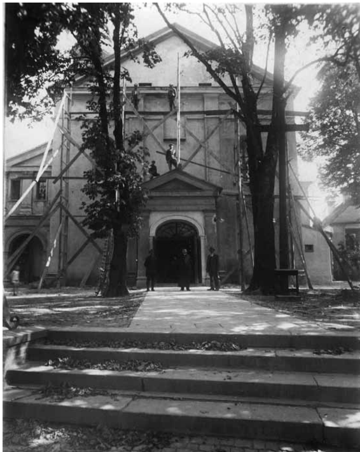
Podczas remontu zewnętrznego kościoła św. Mikołaja
