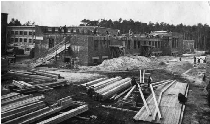
Plac budowy Śląskiego Zakładu Głuchoniemych
