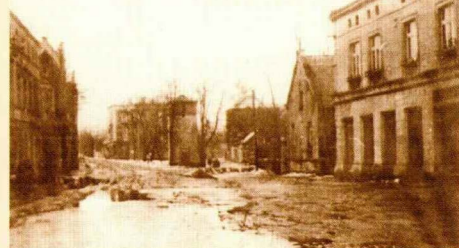
Obecny Plac Kopernika, w głębi widoczny budynek, w którym obecnie mieści się Bank Śląski. Po prawej stronie widoczny budynek, w którym mieściły się restauracje i sklepy, obok szczyt budynku, w którym znajdował się przytułek Szpitalik Fundacji Jana Dobrego Księcia Opolskiego.
