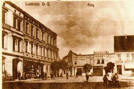
Rynek w Lublińcu, północno-wschodni narożnik, obecnie wylot ul. św. Edyty Stein. Po lewej stronie ciąg hoteli, na wprost dawna fabryka wody sodowej Seller-Fabrik.
