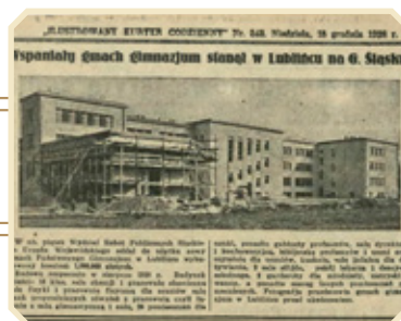
Budowa obecnego budynku szkoły w latach 1928–1929 według projektu Juliana Karola Schayera
