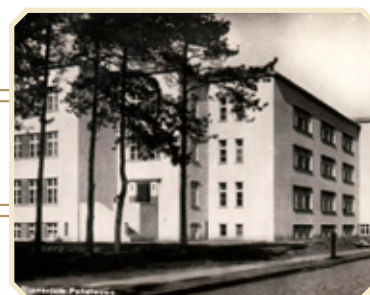
Nowy budynek Gimnazjum Państwowego im. Adama Mickiewicza oddany do użytku 6 grudnia 1929 roku
