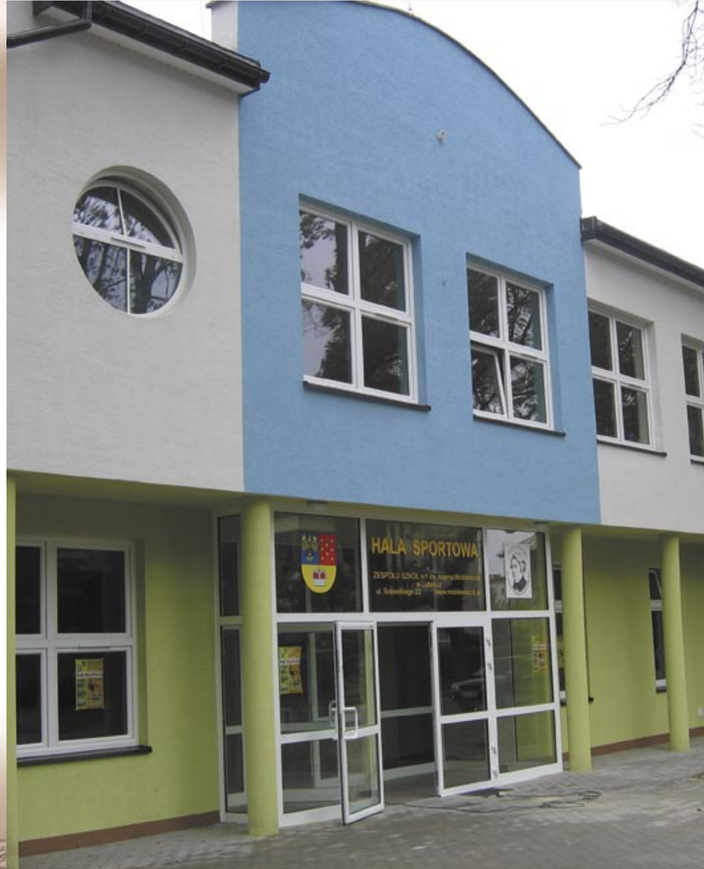
Hala sportowa przy Zespole Szkół nr 1 im. A. Mickiewicza w Lublińcu. Sports hall attached to the A. Mickiewicz Group of Schools No. 1 in Lubliniec.
