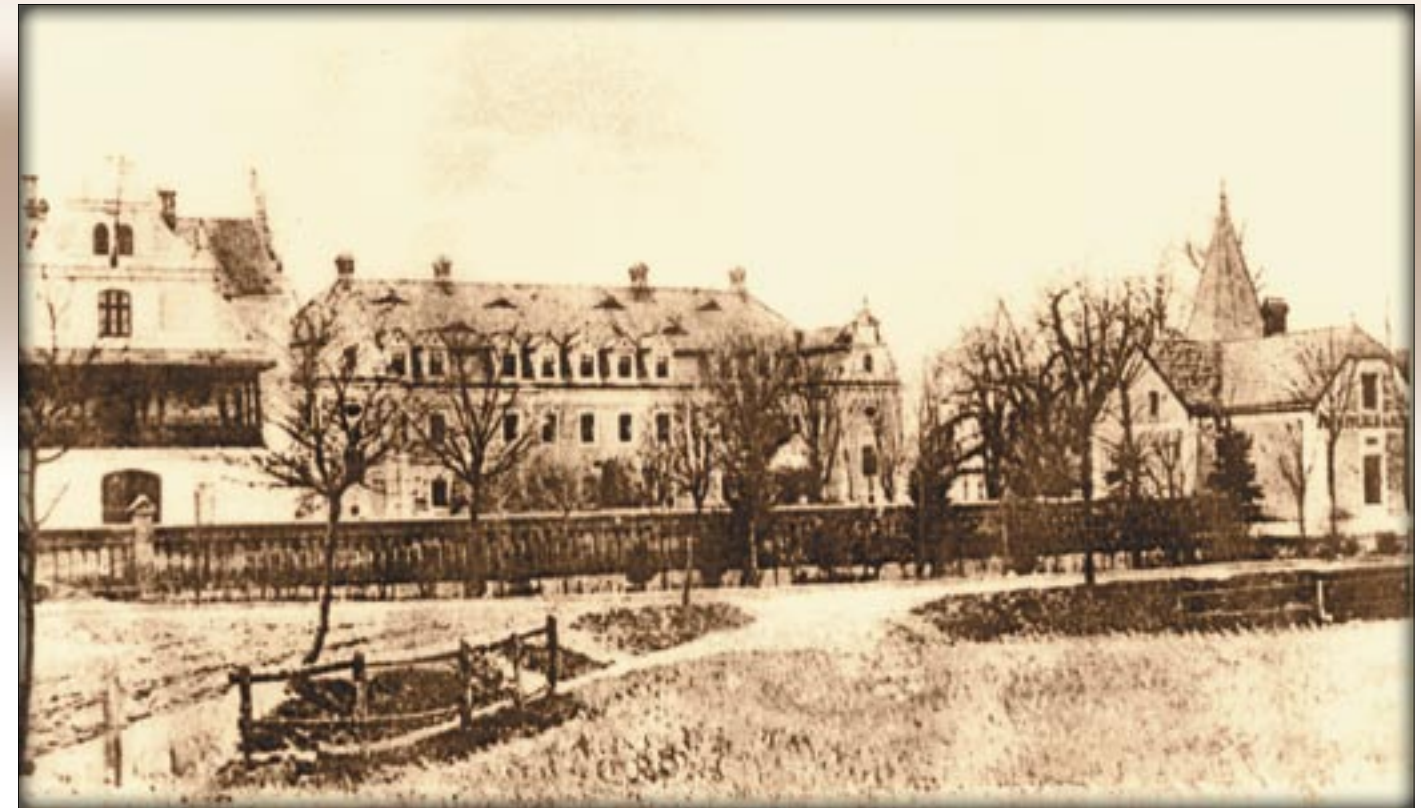
Kompleks zabudowań Szpitala Neuropsychiatrycznego. Po prawej stronie widoczny budynek z wieżyczką z 1894 r. – dawna izba przyjęć. Na pierwszym planie skwerek przy stawie zamkowym. Complex of Neuropsychiatric Hospital building.
