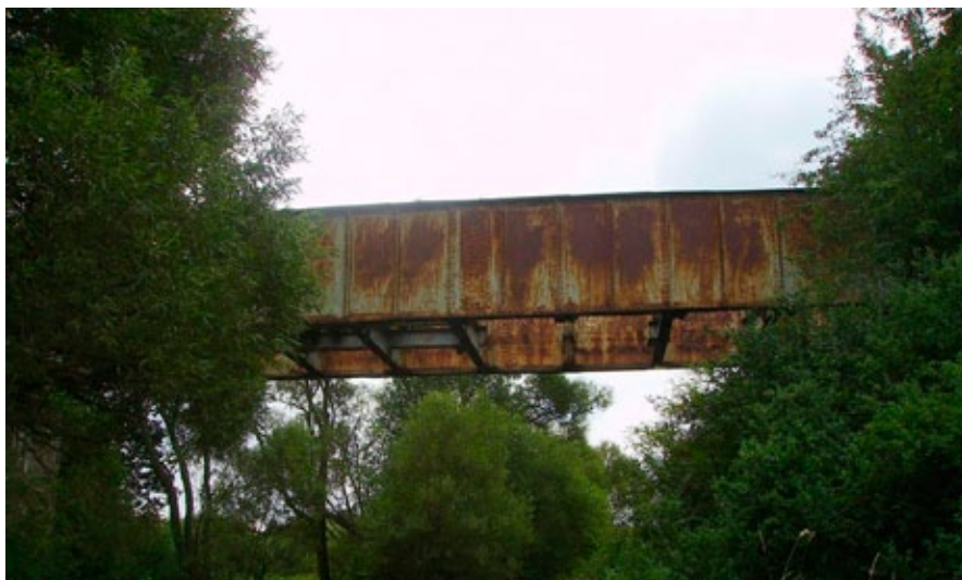
Most w ciągu linii kolejowej Strzebiń – Woźniki, w okolicach stacji Woźniki Śląskie, rok 2010. Fot. A. Kozła, źródło: https://www.bazakolejowa.pl/foto/1034/1279752552-146.jpg , dostęp: dnia 23 lipca 2019 roku
