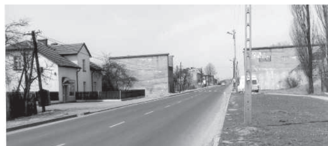
Ulica Oleska z widocznym niedokończonym mostem kolejowym
