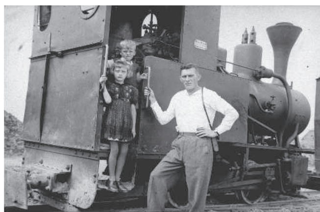
W parowozie na budowie nasypu
