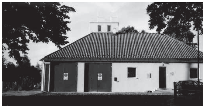
Budynek straży pożarnej w Olszynie po termomodernizacji
