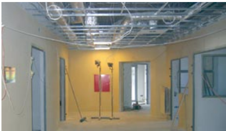
Prace przy budowie Szpitalnego Oddziału Ratunkowego
