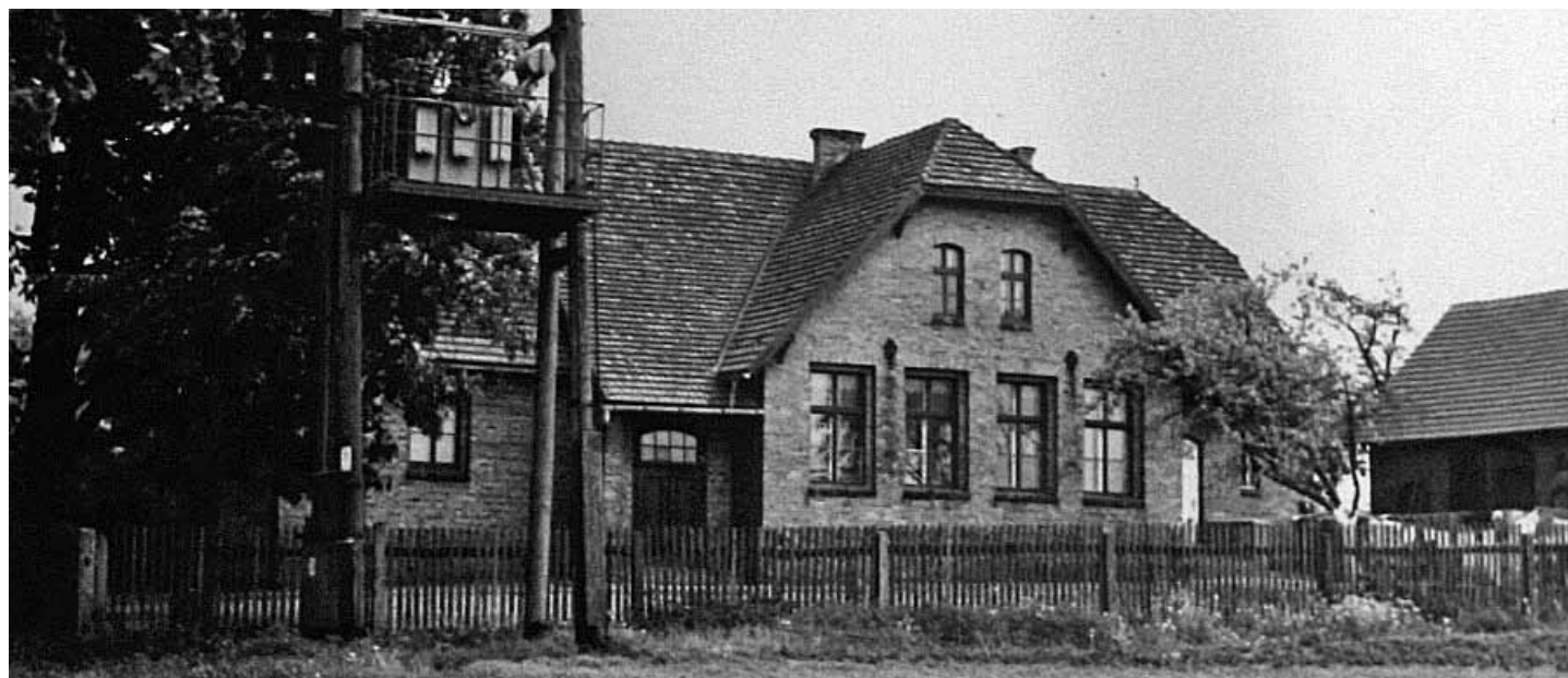
Szkoła podstawowa w Dyrdach. Rok budowy 1902. Źródło: materiał udostępnił pan Olgierd Kniejski
