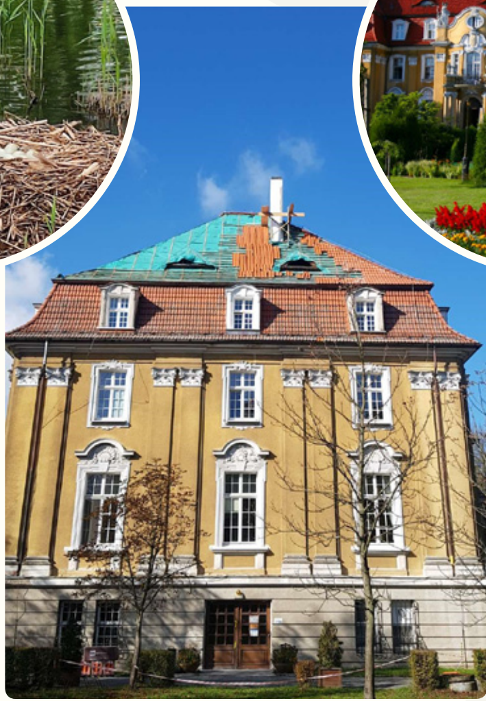
Częściowa wymiana pokrycia dachu (2022 rok)
