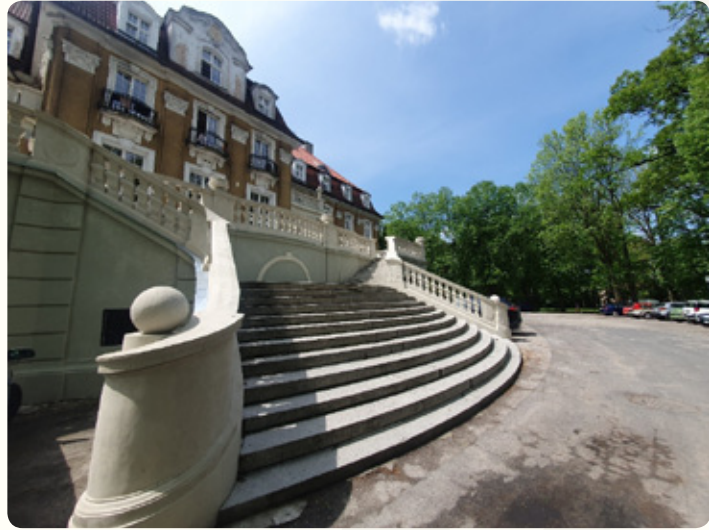
Taras dolny elewacji północno-wschodniej po remoncie
