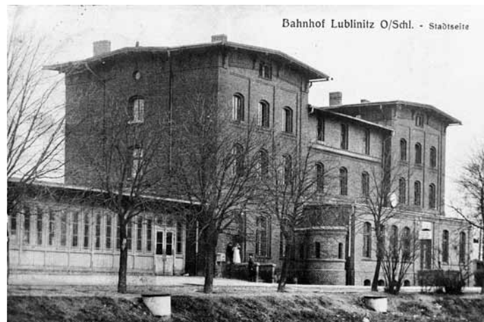
Budynek pierwszego dworca kolejowego w Lublińcu
