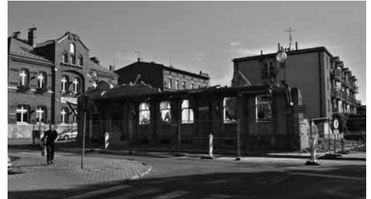
Zdjęcie z sierpnia 2015 r. – prace wyburzeniowe budynku z ok. 1880 roku.
