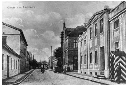
Zdjęcie z 1913 r. – posterunek przed budynkiem sztabu 3 Batalionu 63 PP (przy dzisiejszej ul. Mickiewicza; w głębi, po prawej: budynek poczty, obecnie MOPS).
