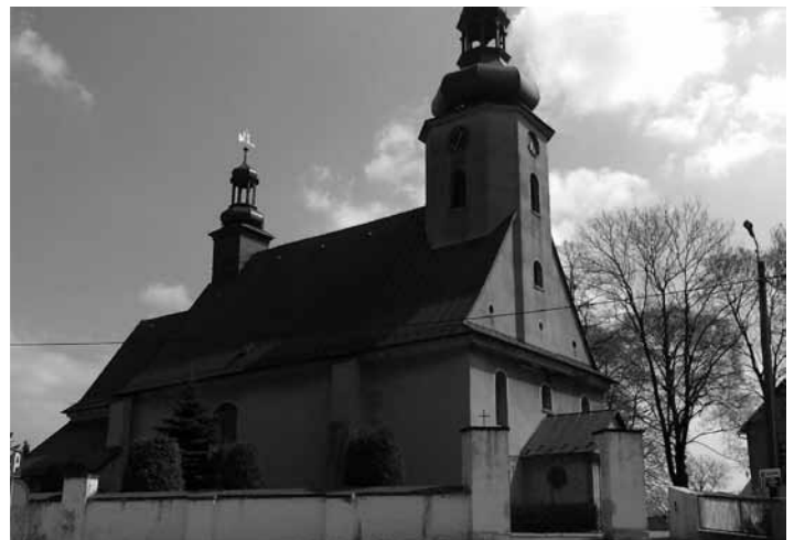
Lubecko, kościół parafialny pw. Wniebowzięcia Najświętszej Marii Panny, archiwum Starostwa Powiatowego w Lublińcu.
